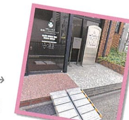
スロープ 出入口の 段差解消に使用
